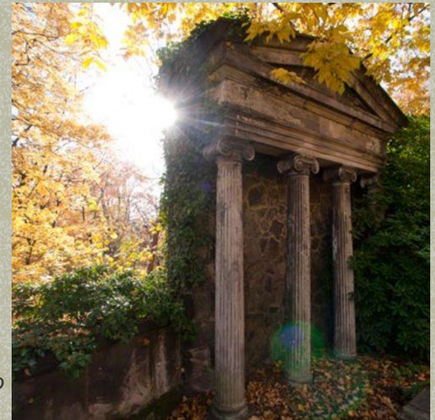
Teil der historischen Friedhofsmauer Część historycznego muru cmentarnego
